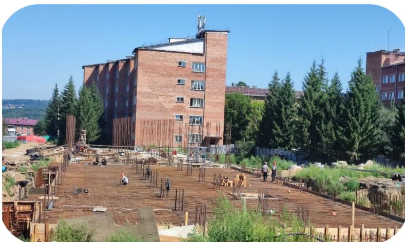
Сейчас отставаний от графика нет. Завершены работы по устройству теплотрассы, системы пожаротушения с установкой пожарных емкостей, подготовлен монолитный каркас цокольных этажей будущих зданий. Идут бетонные работы по перекрытию блоков В, Г и Д. Для Иркутской области строительство корпусов очень важно, так как это позволит улучшить условия проживания пожилых людей и даст им возможность как можно дольше поддерживать физическую и творческую активность.
